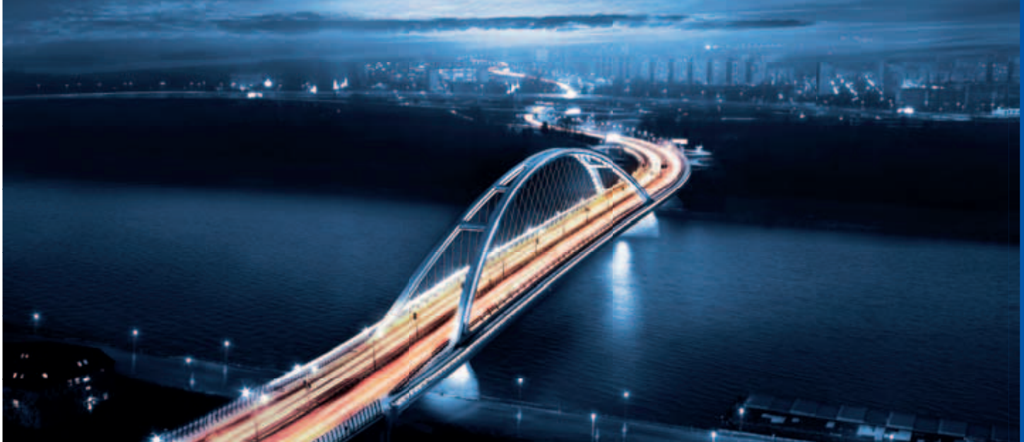
Apollo Bridge, Architects Ing. Miroslav Maťaščík - Alfa 04 a.s., Bratislava Design Dopravoprojekt a.s., Bratislava
